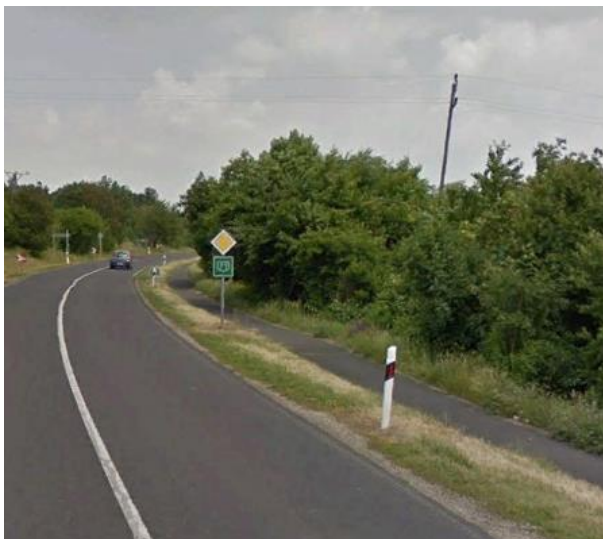
A kerékpárút egy szakasza (jelenlegi állapot) (Forrás: Google maps)
